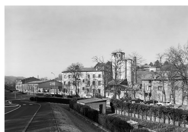
Vue générale est, route de Tarare Phot. Eric Dessert IVR82_20006900064P
