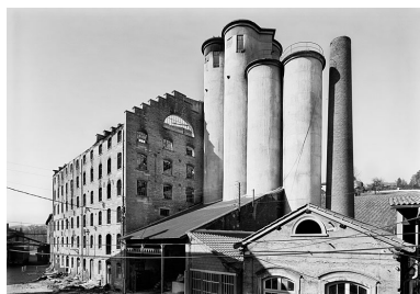
Vue est avec silos en béton et cheminée coupée Phot. Eric Dessert IVR82_20006900068P
